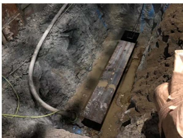
新たな駅をつくる空間を確保するため、アンダーピニング工法により、JR地下街等の既設構造物を仮受杭で支えながら、掘削作業を進めています。
